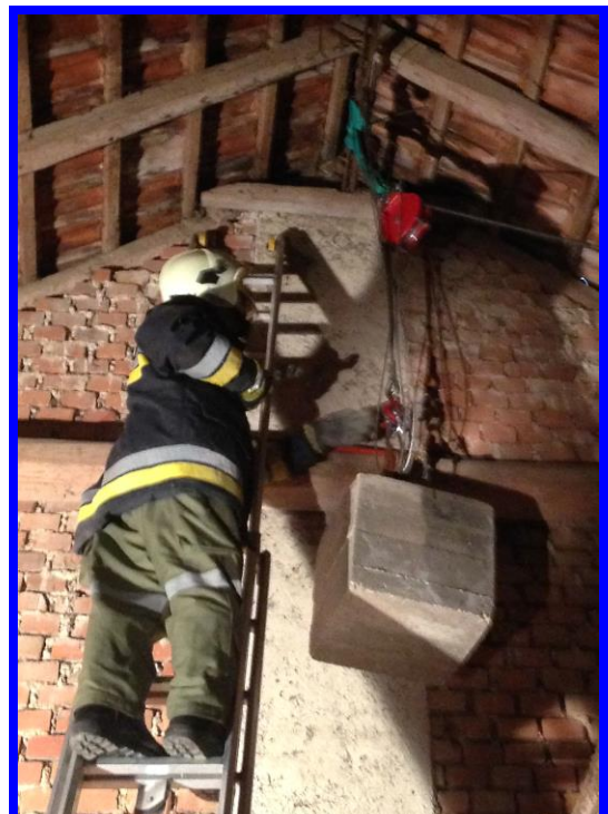
Die Entfernung eines 200 kg Betonklotzes, welches als Gegengewicht einer Greiferanlage diente, wurde von 17 Kameraden durchgeführt. 11. Mai 2016
