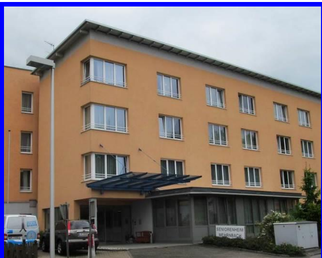
Einen Brandmeldealarm gab es im Seniorenwohnheim Mehrnbach, wozu 17 Mann ausrückten. 16. März 2014
