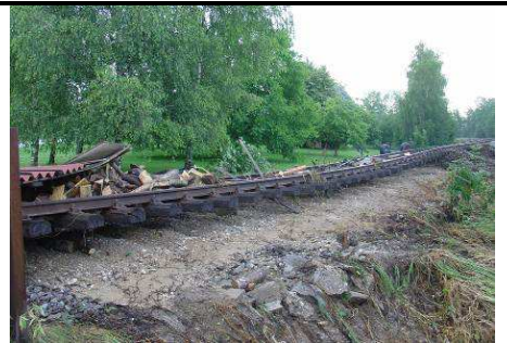
Die unterspülte Bahnstrecke in Abstätten und Atzing
