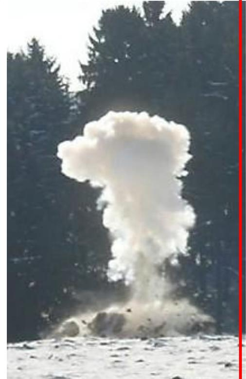
Um einen Abtransport von Findlingen (sog. Mehrnbacher 40iger) aus einem Feld zu ermöglichen, wurde der Sprengstützpunkt Mehrnbach ersucht, diese mittels **Sprengung** zu zerkleinern. Es handelte sich um zwei Steine mit einer Größe von ca. 2 m<sup>3</sup> bzw. 6 m<sup>3</sup>. Da die Sprengstelle mit den Einsatzfahrzeugen nicht erreicht werden konnte, musste die gesamte Ausrüstung mit einem Traktoranhänger zu dieser transportiert werden.
