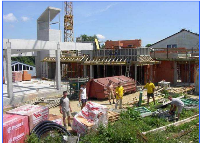
Zügig gehen die Bauarbeiten voran 10. Juni 2008
