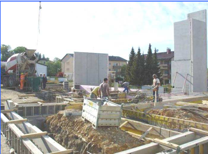
Die ersten Elemente ragen schon aus dem Boden 7. Mai 2008
