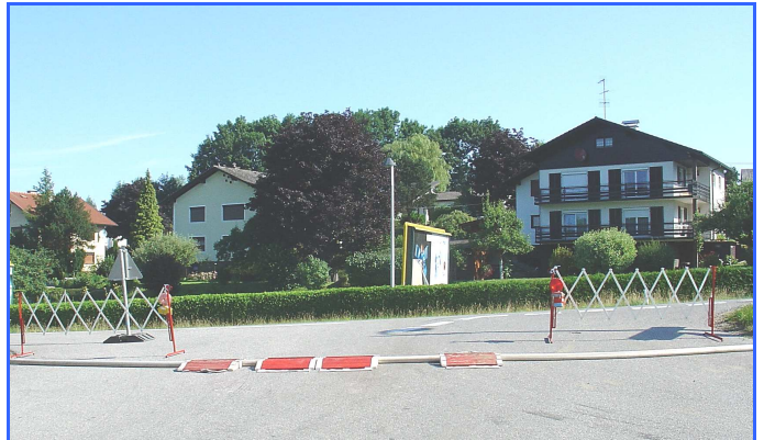
Überbrückungsleitung nach Wasserrohrbruch im Ortswassernetz 5. Juli 2008
