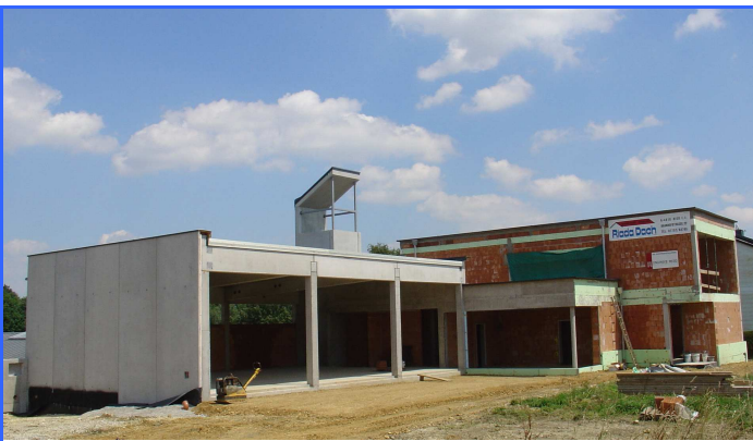
Die Dachgleiche ist erreicht, der Rohbau somit fertiggestellt 16. Juli 2008
