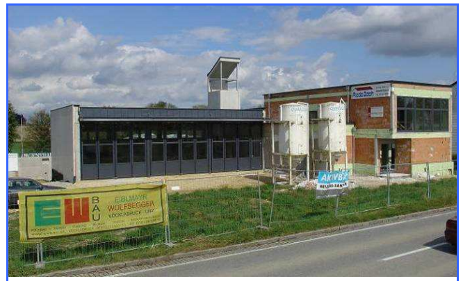
Nach der Sommerpause (Betriebsurlaube) wurden die Tore und Fenster montiert und der Innenputz aufgetragen. 8. September 2008
