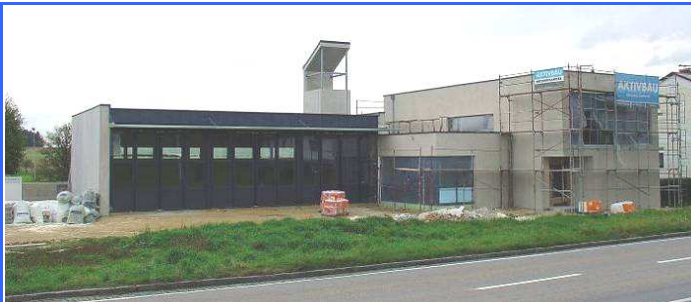
Nachdem nun auch die Portale montiert waren, wurde die Außenfassade in Angriff genommen. 2. Oktober 2008
