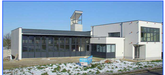
Noch rechtzeitig vor dem Winter, wurde die Außenfassade fast fertig gestellt. 15. November 2008
